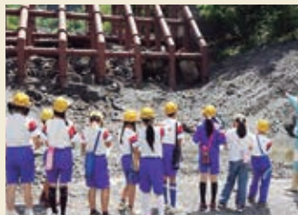
砂防堰堤を見学
