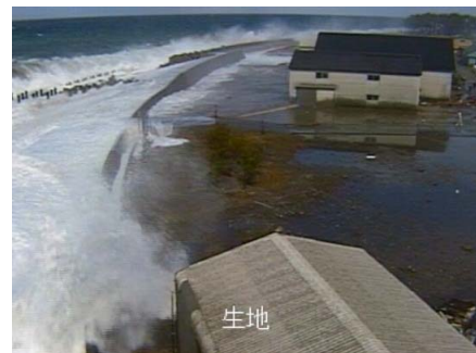
H20.2.24 黒部市生地地先の越波状況
