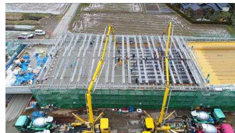
いかるぎの大橋（仮称）上部工施工状況
