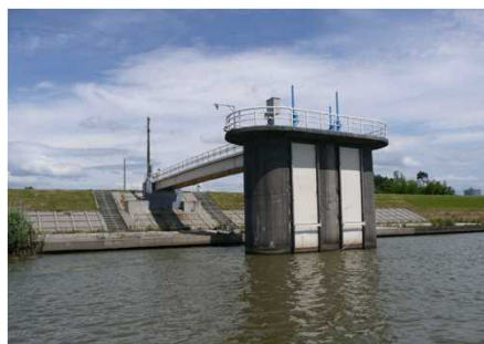
信濃川取水塔(新潟市水道局)
