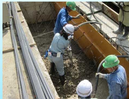
工事現場体験(コンクリート打設)
