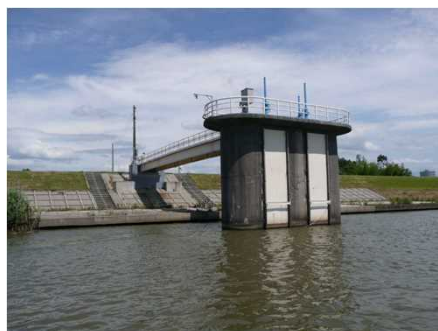
信濃川取水塔(新潟市水道局)
