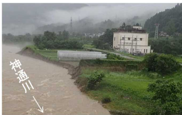
被災状況 撮影日2018.7.7 7時00分
