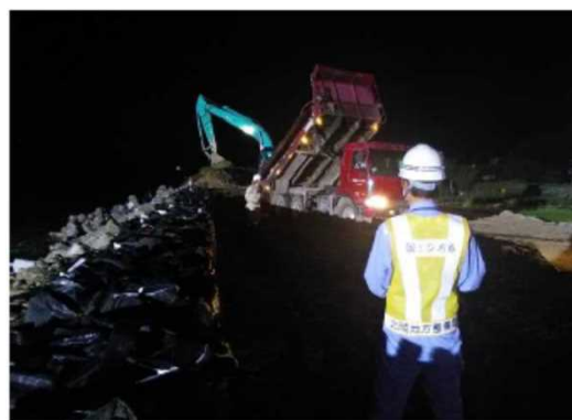
復旧状況 撮影日2018.7.9 20時52分
