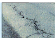
舗装のひび割れ
