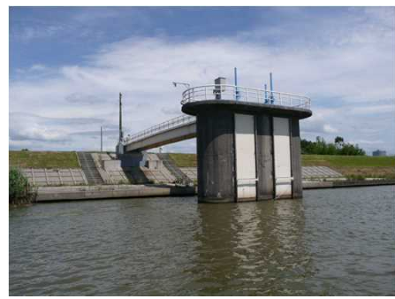
信濃川取水塔(新潟市水道局)
