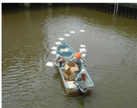
（水質事故での油除去作業の様子）
