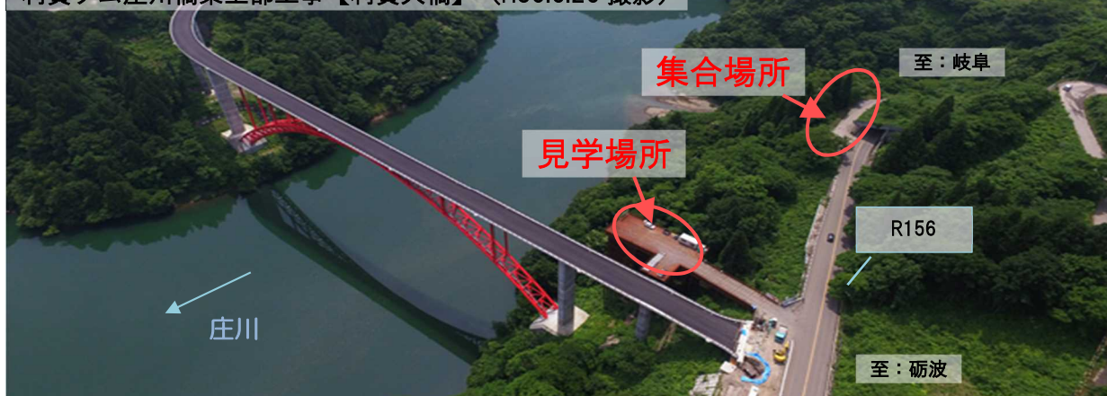
利賀ダム庄川橋梁上部工事【利賀大橋】(H30.6.26撮影)
