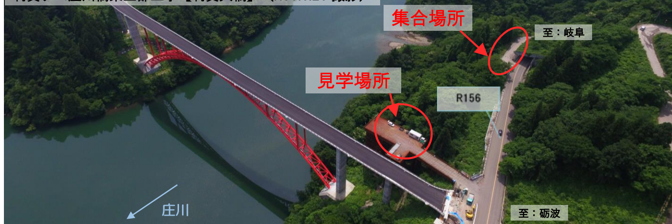
利賀ダム庄川橋梁上部工事【利賀大橋】（H30.6.26 撮影）
