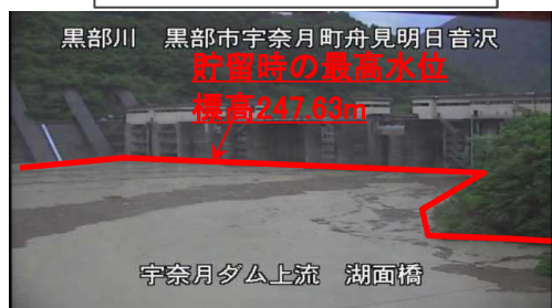
防災操作中の宇奈月ダム
