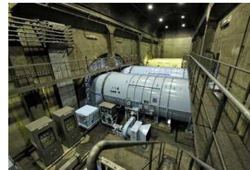
関越トンネル 谷川地下換気所
