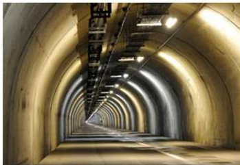
関越トンネル 避難坑
