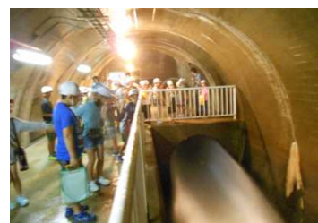
三国川ダム 利水放流水路
