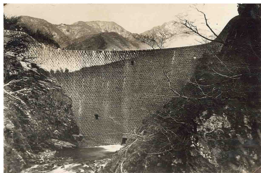
昭和14年 完成当時
