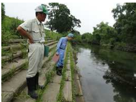
前回の点検実施状況(河川)
