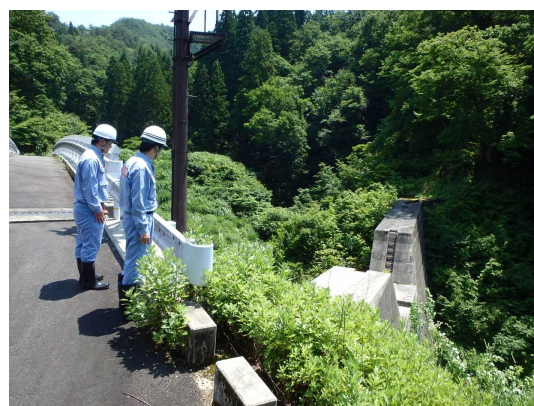
前回の点検実施状況(砂防)
