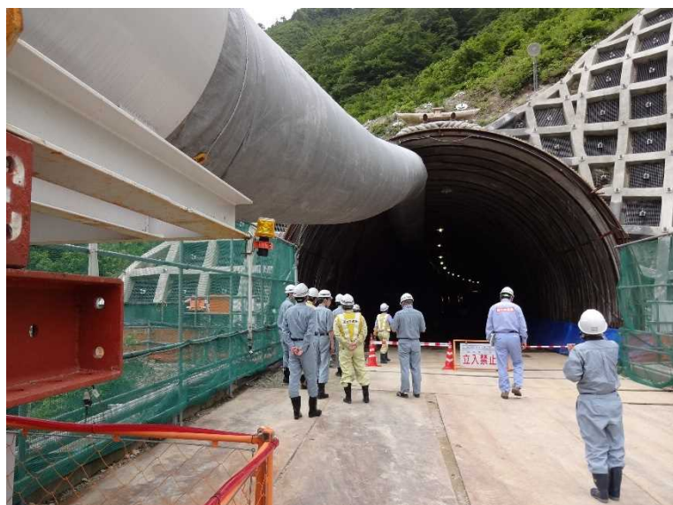
1号トンネル坑口(新潟側) H30. 5撮影
