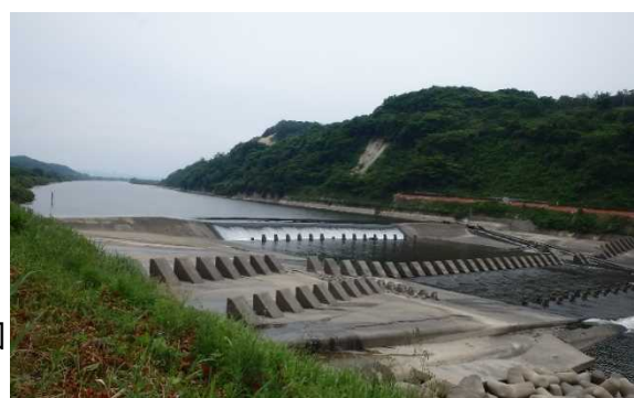
大河津分水路 第二床固 （下流から望む）
