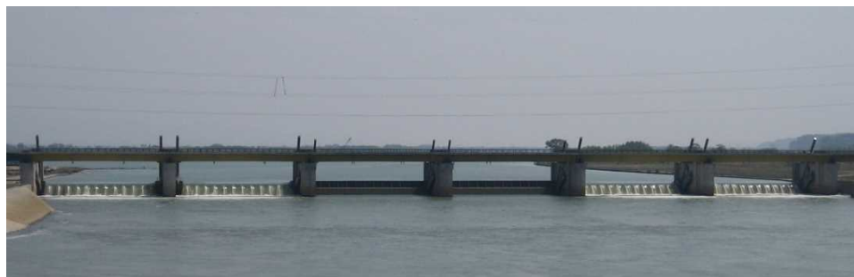
可動堰の放流状況（通常時下流から望む）
