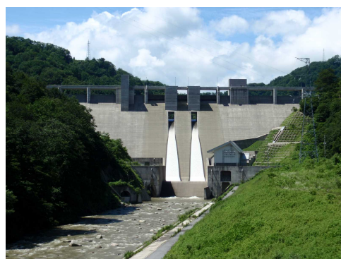
▲オリフィスゲートからの放流
