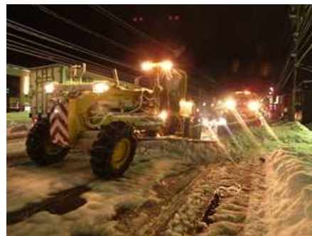
【国道8号富山県高岡市内の除雪状況】
