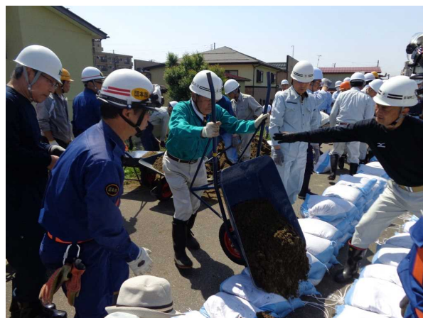
市民による積み土のう工
