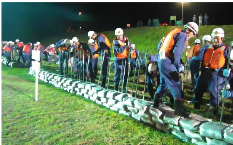
平成29年度 実施の様子（積み土のう工）
