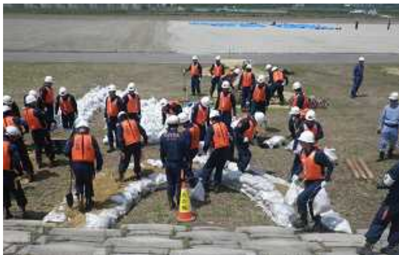
平成29年度 実施の様子（月の輪工）
