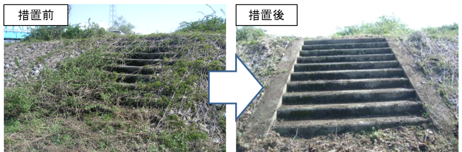
措置の状況（階段の除草）
