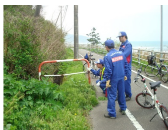
防護柵点検状況
