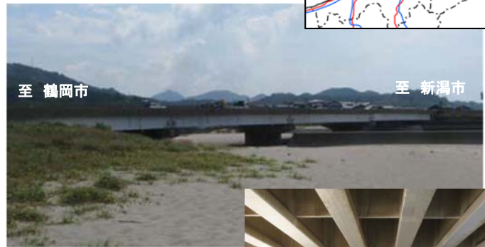
府屋大橋全景
