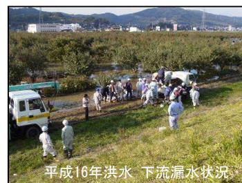
平成16年洪水 下流漏水状況
