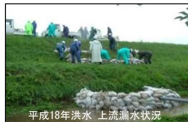
平成18年洪水 上流漏水状況
