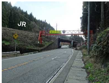
【写真②】2車線の状況
