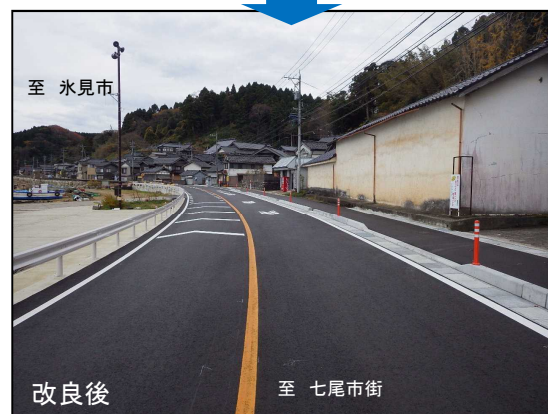
完成した庵歩道
