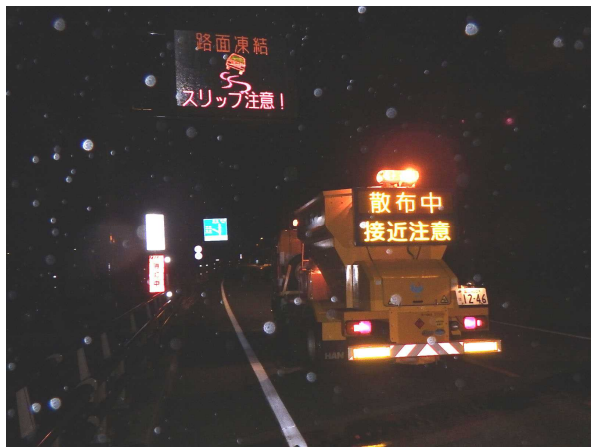
ぬのしり 国道41号富山市布尻地先における作業状況
