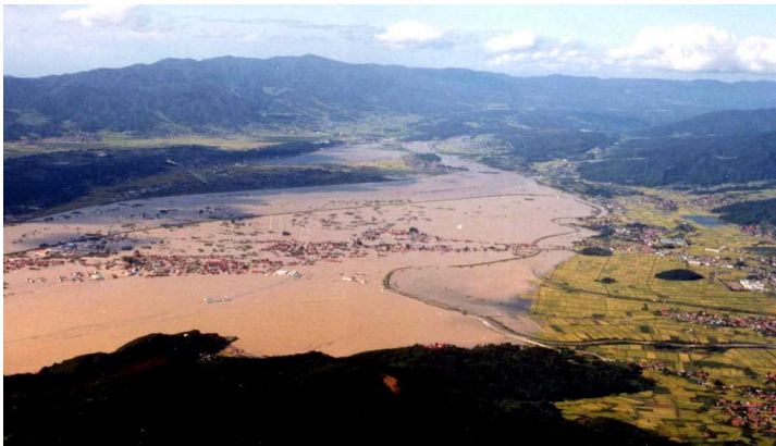
昭和57年樽川の決壊により飯山市木島地区が水没した状況
