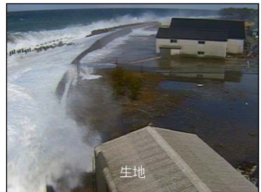
H20.2.24 黒部市生地地先の越波状況
