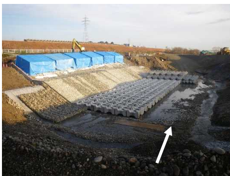
H28年度上伏間江護岸工事施工状況
