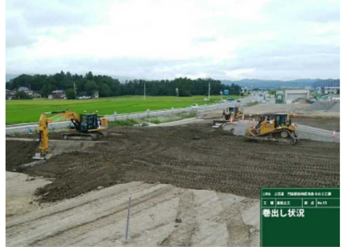
施工状況（路体盛土工 敷均し）
