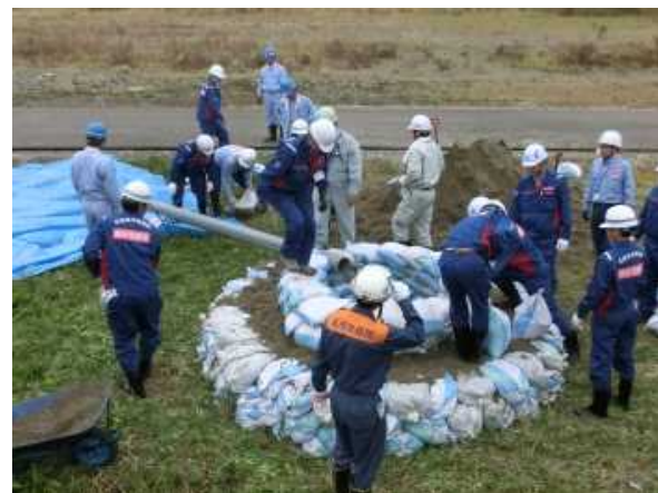
水防工法「釜段」
