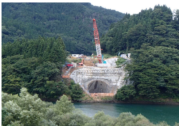
工事の状況(対岸から撮影)
