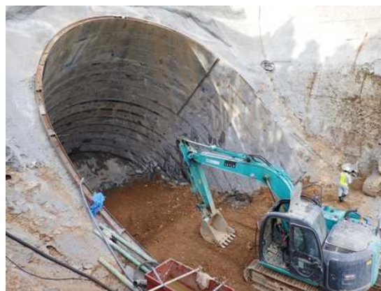
「斜め深礎杭」の施工状況
