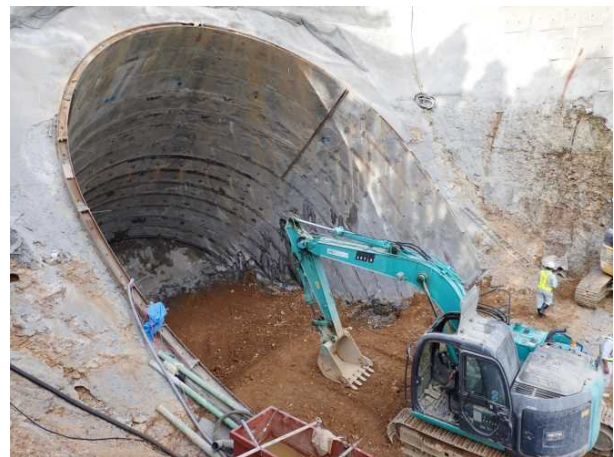
「斜め深礎杭」の施工状況
