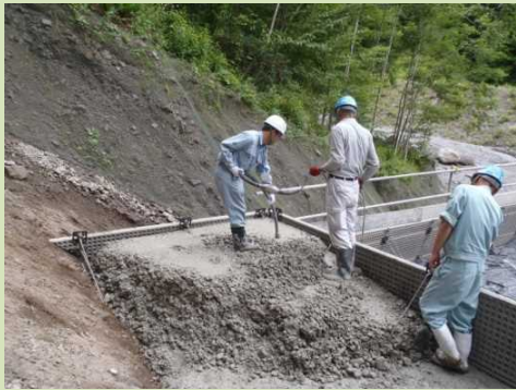
砂防堰堤のコンクリート打設の体験
