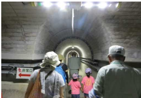
ダム内部見学(堤体内)
