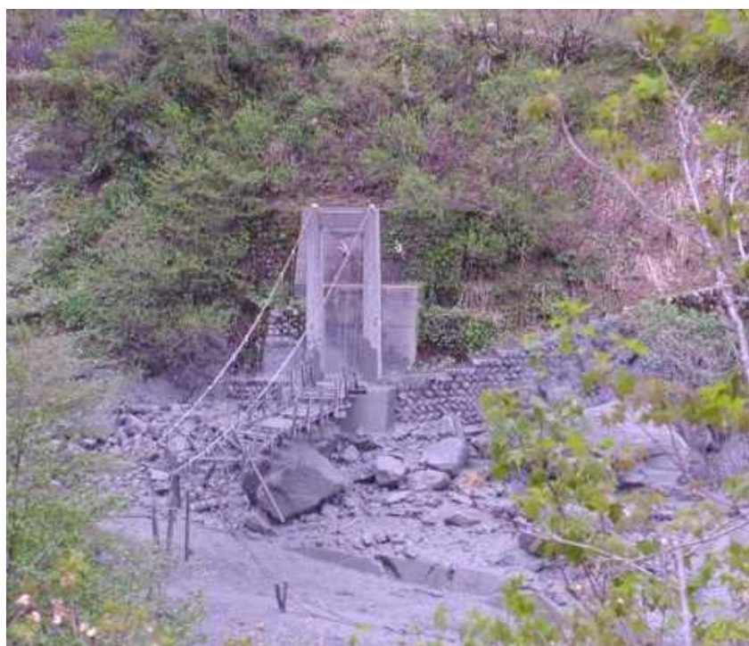
流された吊橋 (H16. 5. 17)
