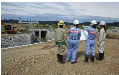
工事現場で打合せを行う女性技術者
