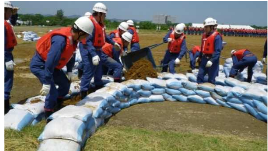
水防訓練（月の輪工法）の様子
