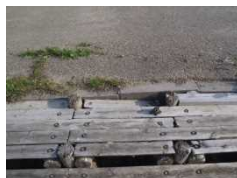
→是正措置完了
