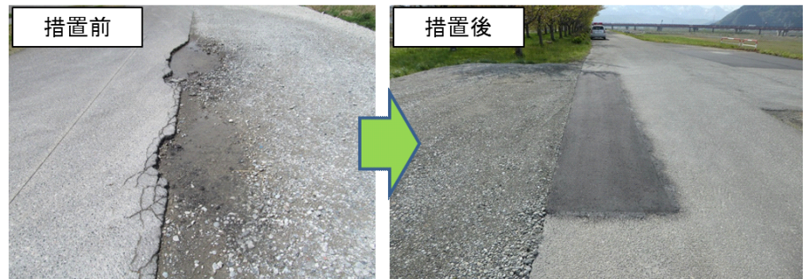
措置の状況（舗装の段差解消）
