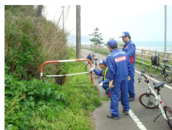
防護柵点検状況
