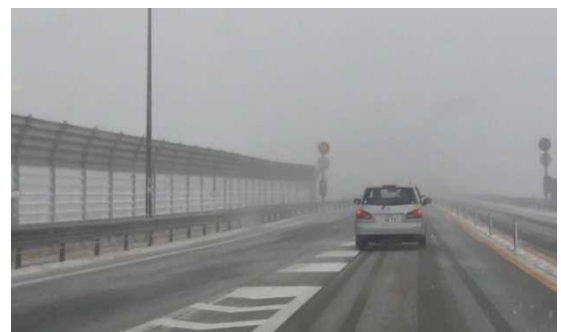
写真：地吹雪防止柵設置箇所（金屋地区）
