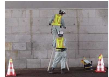
萬代橋が交差している市道上の点検
