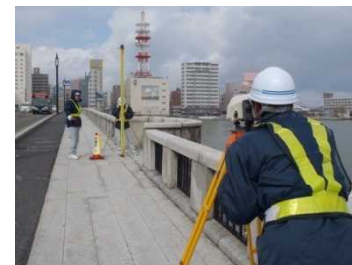
歩道上の測量作業
