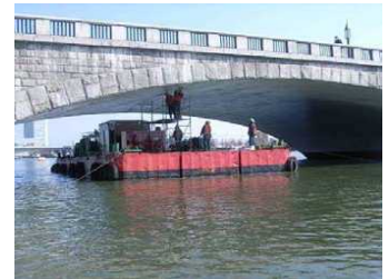
台船による橋梁定期点検
