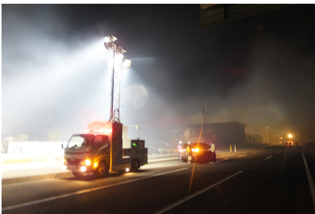
稼働場所：糸魚川市大町2丁目（一般国道8号）
