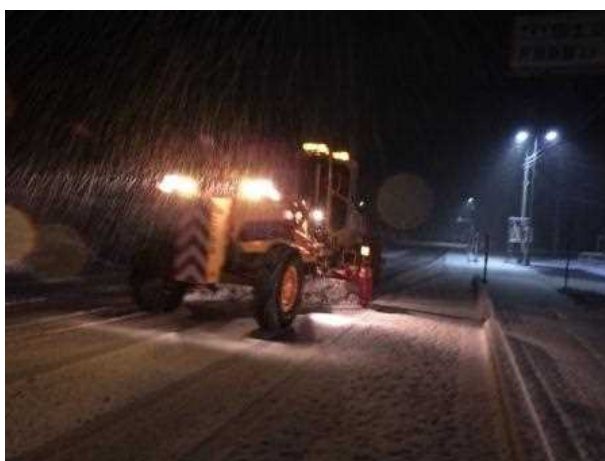
かたかけ 国道41号富山市片掛地先における作業状況
