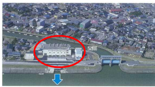
西川排水機場
